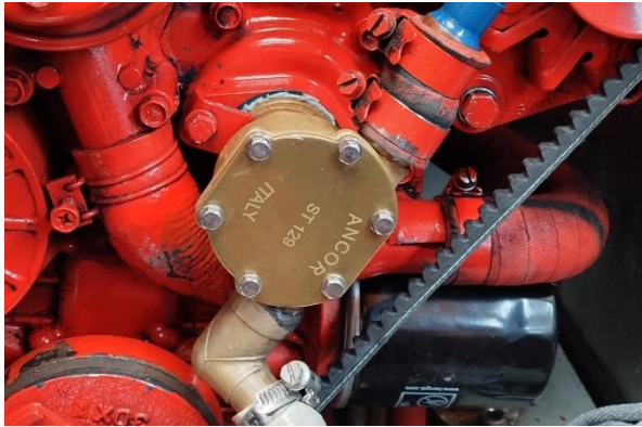
Die neue Seewasserpumpe ist montiert
